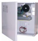
Unità di alimentazione 24 Vcc 10 A. Certificata CE CPD EN54-4 A2 e EN12101-10 per i sistemi di controllo a norma di evacuatori di fumo e calore. Batteria allocabile 2 x 24 Ah 12 V. Corrente disponibile per carichi esterni 8 A. Contenitore metallico (405 x 385 x 160 mm). 3 uscite a relè per mancanza rete, guasto batterie e guasto uscita
